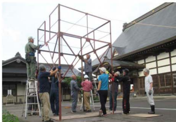
やぐらの組み立て作業を行う3区と9区の地区民
